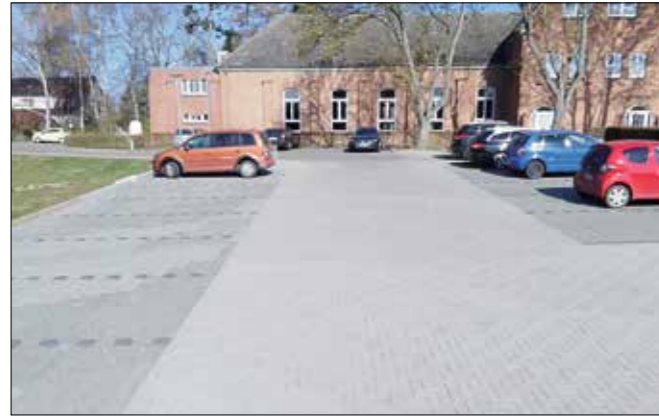
Bau eines Parkplatzes an der Schule (ca. 89.000 Euro)
