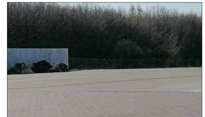
Neubau einer Strandgutaufbereitungsanlage an der Tarnewitzer Umgehungsstraße inkl. Technik (ca. 1.157.000 Euro)
