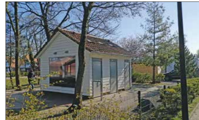
Neubau von 6 öffentlichen Sanitärgebäuden (ca. 1.000.000 Euro)
