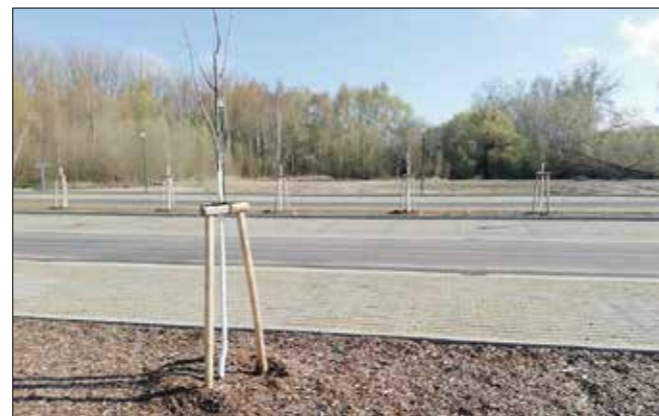
Neubau eines Großparkplatzes in Tarnewitz (ca. 941.000 Euro)
